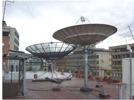
気象局屋上のアンテナ群
